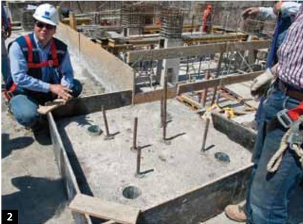
2. El capitel se hormigona incluyendo los tubos en que se instalará el dispositivo. Es necesario medir el nivel de los soportes del dispositivo para asegurar su correcto funcionamiento.
