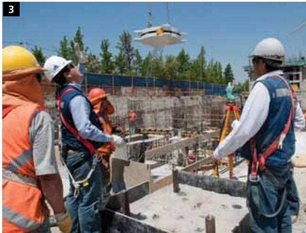
4. Para la instalación del dispositivo se requiere de por lo menos cuatro profesionales, que paralelamente deberán atornillar los pernos del aislador.
