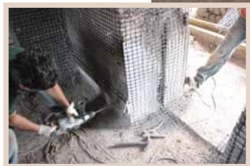
El principal desafío fue incorporar la geomalla a una obra existente ya que la técnica original involucra la malla desde las fundaciones; para esto los arquitectos diseñaron un sistema de prensas de madera que muerden la malla contra el zócalo del muro en sus dos caras. Para ello, se utilizó una broca especial capaz de atravesar un muro de 60 cm de ancho de lado a lado y así completar el proceso de sujeción.
