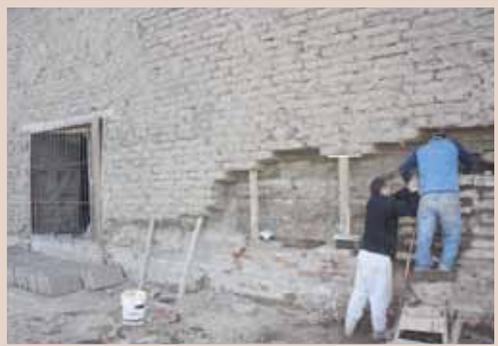
◀ En el sistema de muros de bloques de adobe, estos deben ir entretrejididos en ambos sentidos (eje x - eje y) para que el sistema estructural funcione correctamente no pueden haber bloques cortados, por lo que se removió todo el revoque interior y exterior de la construcción para poder identificar los bloques quebrados y reemplazarlos.
