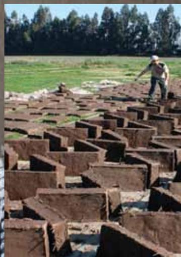
Se hicieron alrededor de 5.000 bloques de adobe nuevos de las mismas dimensiones de los existentes (60 x 30 x 10 cm.). Los bloques se forman con tierra del lugar, paja y arena fina. La mezcla se vierte en moldes de madera con aceite quemado y luego los bloques se dejan secar a la intemperie durante tres semanas.
