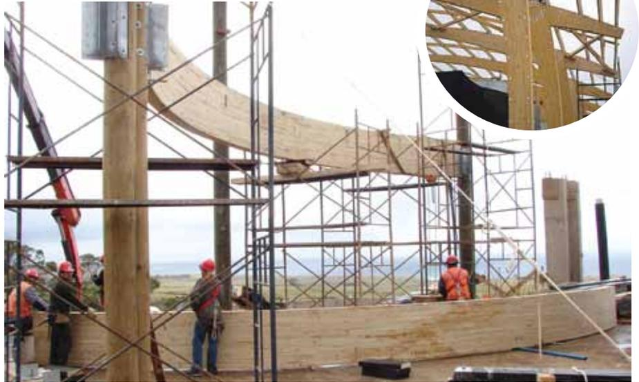
tantes en las dimensiones de las piezas de madera laminada. Contra la creencia popular, el perno resulta un medio de unión de limitada eficiencia, ya que puede experimentar grandes deformaciones en uniones en las que se deben traspasar fuerzas mayores entre las piezas de madera, las que a su vez sufren aplastamientos considerables en las vecinda-
