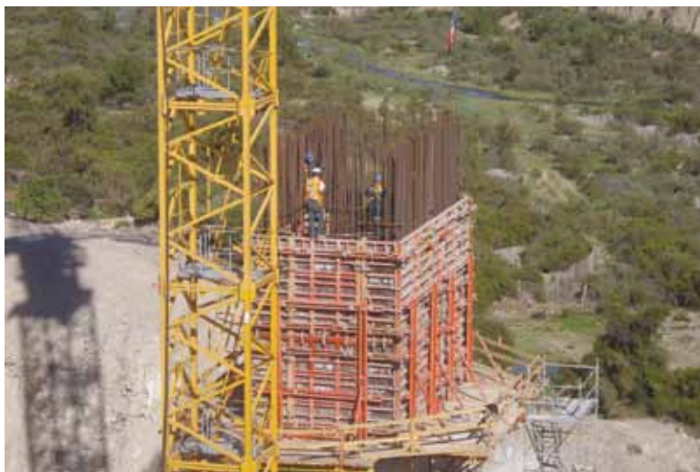
Secuencia de construcción de las columnas o pilas que dan soporte al puente. Para su ejecución, se utilizó un sistema de encofrado trepante en tramos de 5,4 metros.
