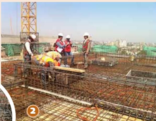
Desde la misma losa de cubierta se ubican las enfierraduras de los capiteles de hormigón armado que posteriormente recibirán a los aisladores. Estos capiteles contienen los insertos metálicos necesarios para apernar los aisladores.
