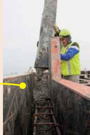
La masa está conformada por un cajón que se arma siguiendo los pasos tradicionales para cualquier estructura de hormigón armado. Se utilizan moldajes para realizar tanto lo que serán las paredes exteriores, así como para las divisiones internas. Este cajón posteriormente será llenado con acero para aumentar el peso del AMS.
