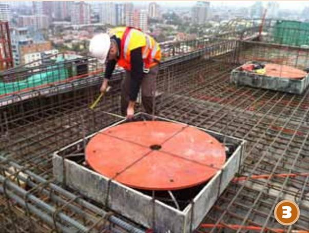
La estructura de soporte de los AMS comienza a tomar forma. Se construyen cuatro capiteles de hormigón. A ellos se fijarán con pernos, los aisladores elásticos que soportarán la masa. Estos se fabrican con capas intermedias de goma natural y planchas de acero que otorga firmeza y flexibilidad a la vez. Por fuera llevan una cubierta de neopreno, que aporta mayor resistencia a las inclemencias del tiempo y los rayos del sol.
