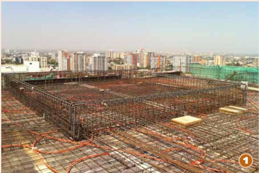
La instalación del sistema AMS comienza antes de hormigonar la losa de la cubierta. Las dos masas se apoyan sobre la losa, la cual debió ser reforzada con barras de acero adicionales y vigas invertidas que permiten sostener el peso de los AMS.
