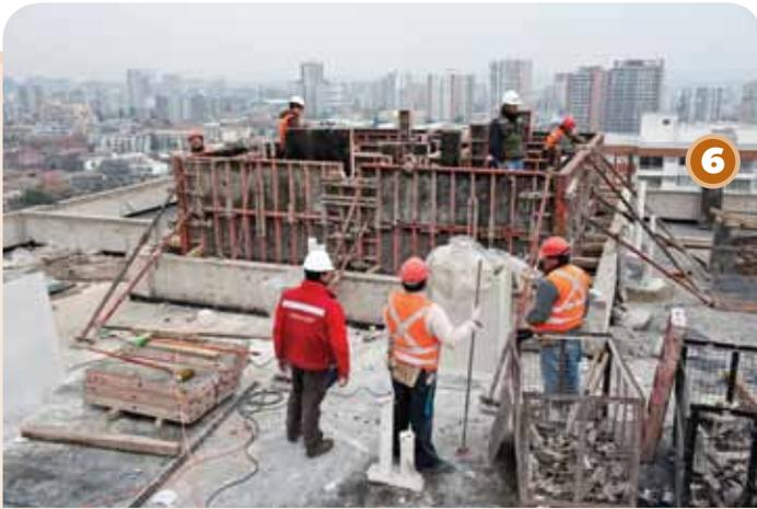
El paso siguiente es construir el esqueleto de la masa, un cajón de hormigón y enfierradura de acero. Para ello se fijan los moldajes, reforzados con puntales, para dar su forma y altura. En este punto es importante verificar la verticalidad y correcta ubicación de los moldajes.
