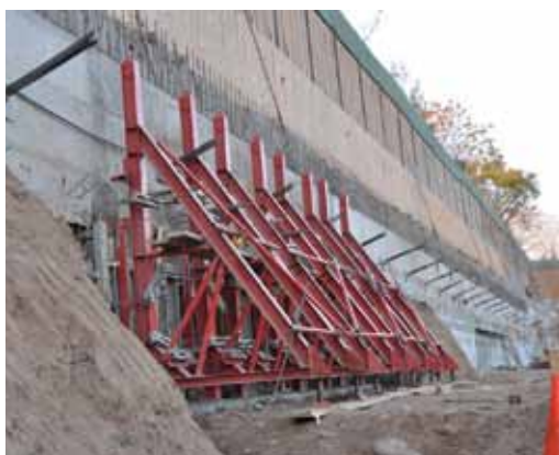
Escudras para muros contra terreno resistiendo vaciados a gran altura.
