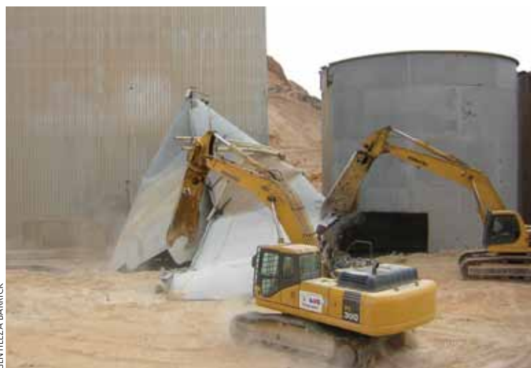
El desplome de las instalaciones fue realizado mediante equipos cortadores (tijeras).
