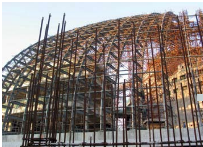
148 vigas de acero tipo Vierendeel forman la cúpula del teatro. Éstas fueron encastradas sobre una base de losa celular de hormigón a 4 m de profundidad.
