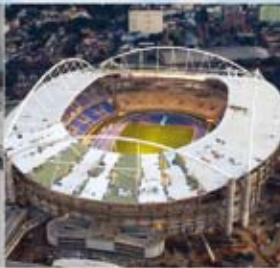
Revestimiento con membrana TPO Firestone
