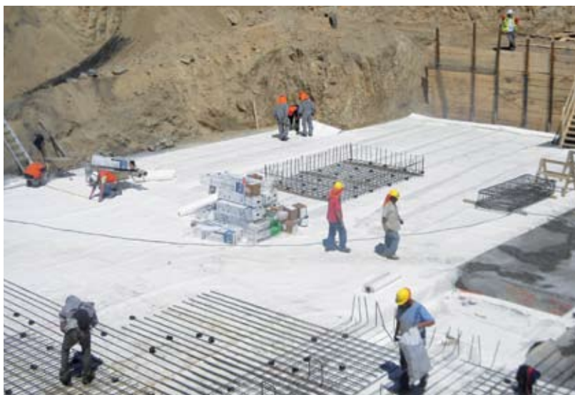
Nov. 2010, obra Vista Villuco, Constructora Socovesa, Instalación de Sistema Preprufe, único en el mundo.
