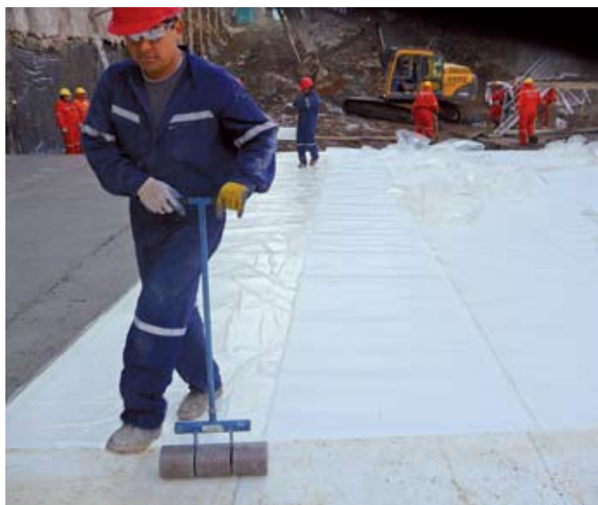
Marzo 2011, Fácil instalación. Traslapes autoadhesivos.
