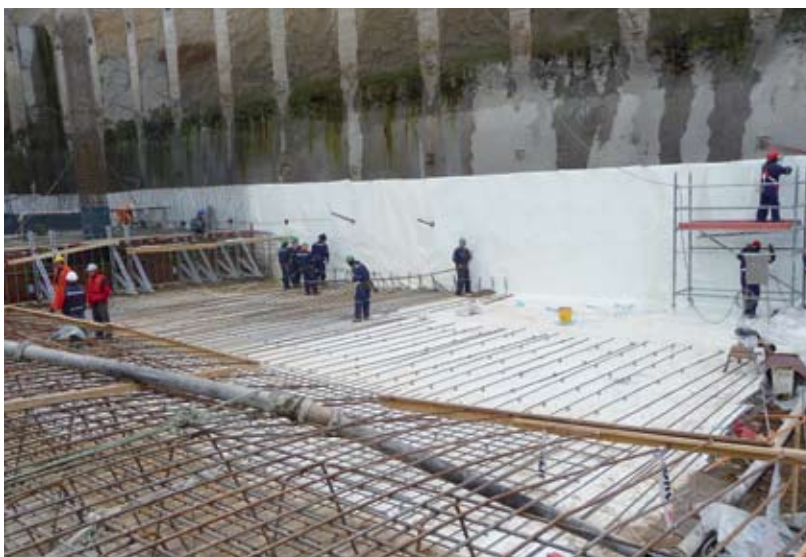
Marzo 2011, Obra Multicentro Talca, Constructora Tecsa. Instalación de Sistema Preprufe, con gran cantidad de agua presente en la obra. Arq. Mauricio Zulueta.
