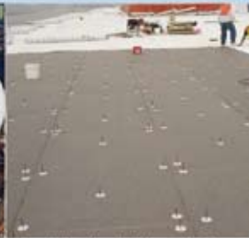
Instalación de Placas ISO 95+ de Firestone
