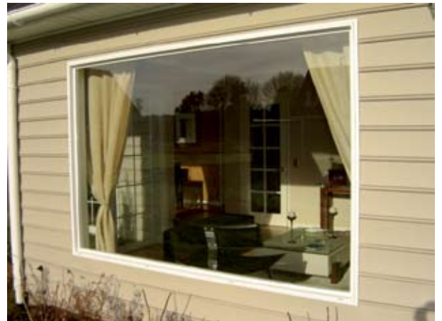
Como revestimiento exterior están hechas en base a vinyl siding en colores y ventanas de PVC.
