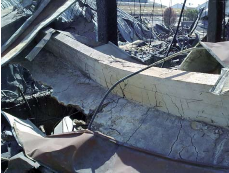
La viga presenta una falla incipiente a momento positivo. Se puede observar la importante deformación producida por los efectos de la temperatura, junto con grietas verticales propias de la falla descrita.
