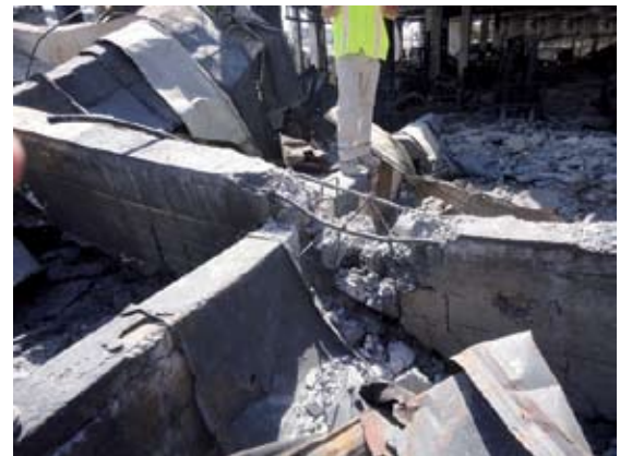
Viga colapsada por el incendio.
