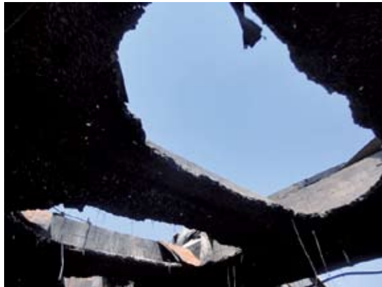
Se aprecia la falla de la losa a momento positivo, permaneciendo en su lugar las zonas a momento negativo.
