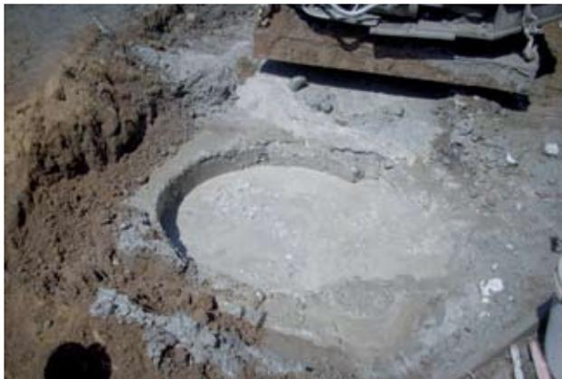
con la ejecución una gran parte de las fundaciones –consistentes en pilotes de hormigón armado, pre excavado– que sostendrían la estructura que uniría los andenes y el nuevo edificio, con la antigua estructura.
