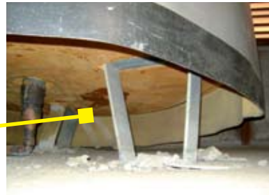
Estanque de agua caliente desplazado de su base a causa de un anclaje insuficiente.
