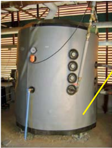
Estanque de agua caliente desplazado de su base a causa de un anclaje insuficiente.
