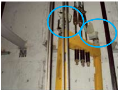
Tanto los guidores como los lubricadores del contrapeso sufrieron daños.
