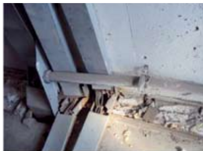
Tanto los guidores como los lubricadores del contrapeso sufrieron daños.
