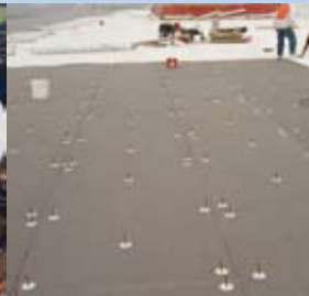
Instalación de Placas ISO 95+ de Firestone
