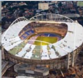
Revestimiento con membrana TPO Firestone
