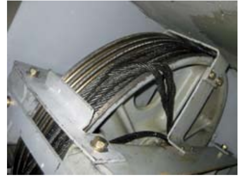
Cables que quedaron desmontados de la máquina de tracción.
