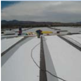
Instalación de Placas ISO 95+ y membrana TPO de Firestone
