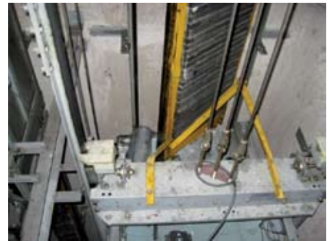
Contrapeso descarrilado que se estrelló contra la cabina. Estos elementos tienen un peso.
