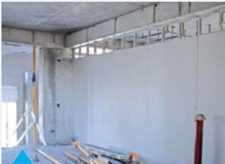
Las placas se instalan alineadas en su altura, lo que hace que el tabique esté más debilitado en la junta horizontal que se produce en la parte superior del tabique. En tabiques en altura las placas deben ir alternadas (traslapadas) en su altura. Las juntas no serán coincidentes en una misma línea.
