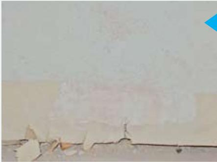
La placa no se deja dilatada y se produce deterioro en la parte inferior del tabique, debido a la falta de espacio para acomodar movimientos de éste. Se recomienda dejar la placa dilatada 10 mm del piso para evitar la humedad por capilaridad y para acomodar movimientos de los elementos constructivos.
