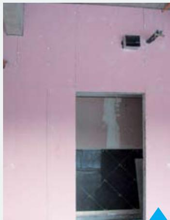
En vanos no se podrán realizar juntas en los montantes del dintel, ya que debilitan la unión. Los vanos deberán reforzarse y se evitarán juntas en las esquinas, que deberán traslaparse con un corte bandera, o bien utilizar una pieza pasante horizontal.
