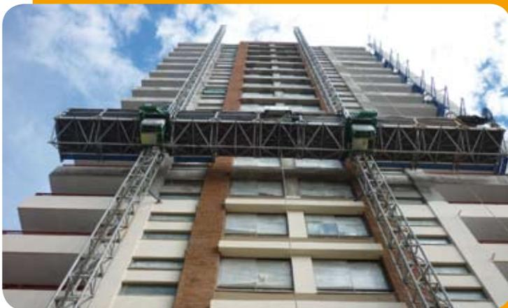
Ambas estructuras son completamente galvanizadas y poseen un sistema de freno de emergencia centrífugo, lo que asegura mayor suavidad y estabilización de la carga. "Estas plataformas se pueden unir entre ellas para abarcar mayor superficie y solucionar distintos requerimientos. También, se adaptan al perímetro de fachadas, ya que cuentan con extensiones de acercamiento de hasta 2,50 m útil," señala Jaime Danus, gerente de la división.
