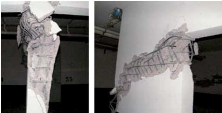
Descensos verticales en cabezas de muros con eventuales desplomes que se traducen en desplazamientos horizontales en niveles superiores.
