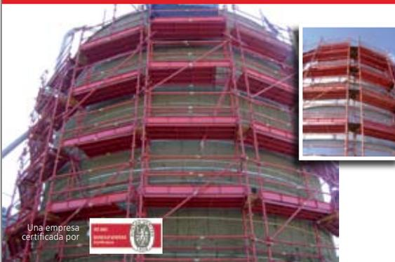
Innovación es colocar un producto o servicio inexistente hasta el momento a disposición de los clientes. Form Scaff y su sistema de andamios Kwik Stage entrega andamios para aplicaciones circulares con continuidad total en el perímetro con flexibilidad de niveles y plataformas. Barandas de seguridad en varios niveles y rodapie exterior e interior complementan dando seguridad.
