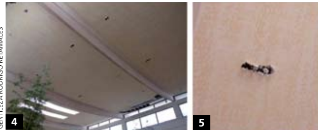
1. Colgador pandeado. 2 y 3. Interacción del rociador con el cielo falso. 4 y 5. La cabeza del rociador rompió el cielo falso.
