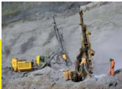
EXCAVACIÓN EN ROCA
