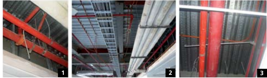
1. Colgador pandeado. 2 y 3. Interacción del rociador con el cielo falso. 4 y 5. La cabeza del rociador rompió el cielo falso.
