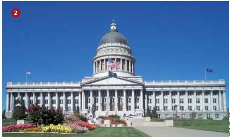
UTAH STATE CAPITOL BUILDING 1. Corte del modelamiento en 3D de la estructura con la solución propuesta. 2. Construido en 1915, el edificio fue rehabilitado con aisladores sísmicos basales.
