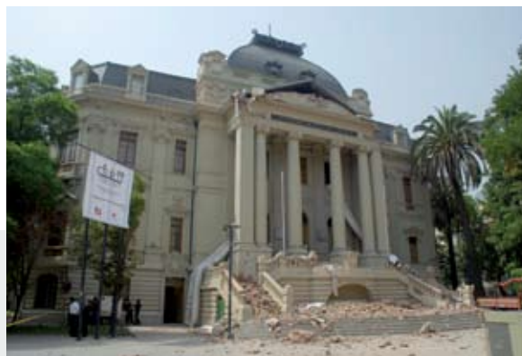
El Museo de Arte Contemporáneo resultó con daños en su fachada y en áreas interiores.
