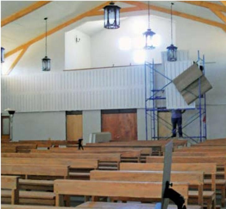
lamiento acústico es la existencia de puertas, ventanas, sistemas de climatización u otros ductos que pudieran atravesar los muros del recinto a aislar. Esto tiene su explicación: cada uno de ellos tiende a ser un elemento débil acústicamente dentro de la estructura, obligando a buscar soluciones adicionales para evitar la fuga de ruido.
