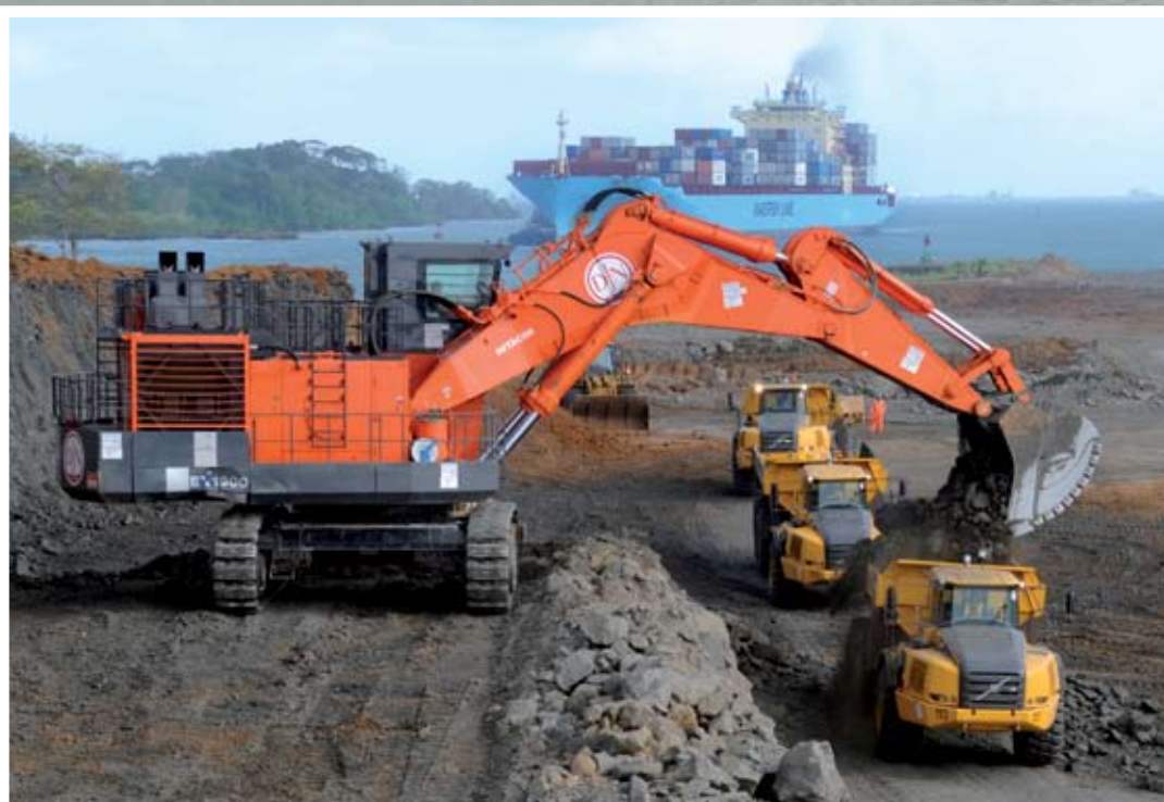
Las faenas de excavación avanzan en el Pacífico y Atlántico. Se estima que la obra será inaugurada en 2014.
