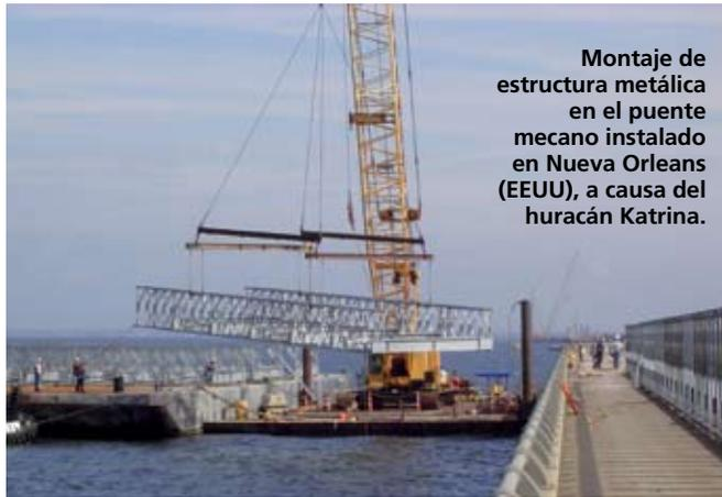
Montaje de estructura metálica en el puente mecano instalado en Nueva Orleans (EEUU), a causa del huracán Katrina.
