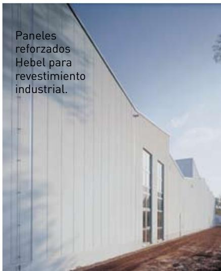
Paneles reforzados Hebel para revestimiento industrial.
