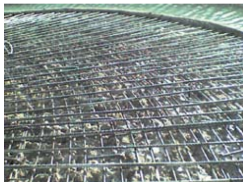
Resultado de la Hidrodemolición
