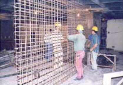
1. Pantallas en hormigón reforzado
