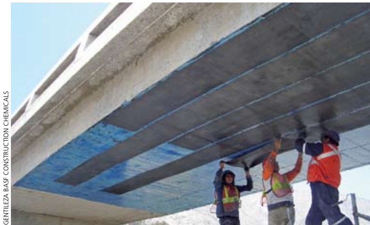
Refuerzo estructural en base a fibra de carbono MBrace® siendo aplicado en una pasarela.
