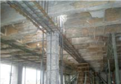
3. Encamisados en hormigón
