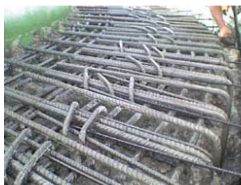
Aspecto final de la armadura tras Hidrodemolición.
