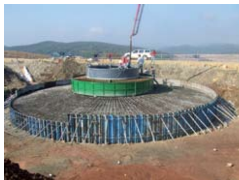
Ejecución del basamento del aerogenerador.
