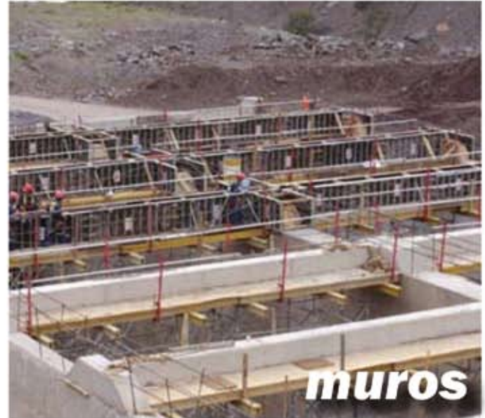
OBRA DESARENADOR AZUFRE HIDROELECTRICA LA HIGUERA
