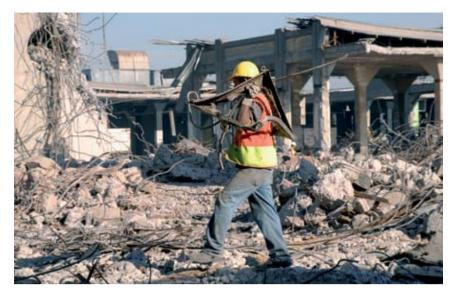
la enfierradura de la base y provocar el volcamiento tirando del cable de tracción. La estructura debe demolerse una vez que se encuentre estable en el piso. En el caso de muros de hormigón, el procedimiento es el mismo con la salvedad, que deben ser divididos en segmentos de 2 m de largo para efectuar en cada uno de los segmentos el mismo procedimiento.
