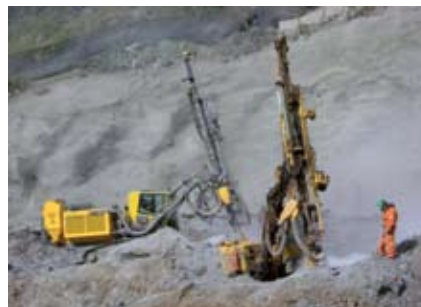
EXCAVACIONES ABIERTAS EN ROCA
