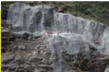
SOSTENIMIENTO DE TALUDES
