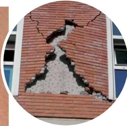
■ Tras el terremoto, los revestimientos de algunos edificios resultaron seriamente dañados, como se aprecia en la imagen.
