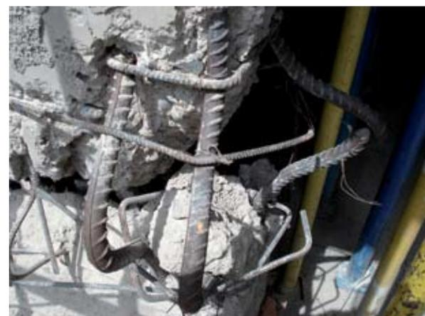
■ Según los expertos, en este terremoto, se han visto fallas por compresión o tracción. Al comprimirse el hormigón, si no está suficientemente confinado mediante estribos o zunchos, el hormigón falla y las barras verticales se pandean y doblan, y cuando viene el movimiento hacia el lado contrario, se estiran y se cortan.
