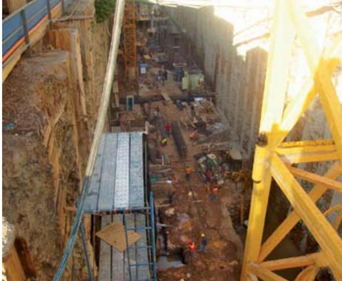
La excavación fue bastante atípica. Su angostura complicó las maniobras de extracción de tierra y a los giros de las máquinas y camiones.
