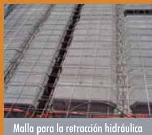
Colocación de bovedillas
