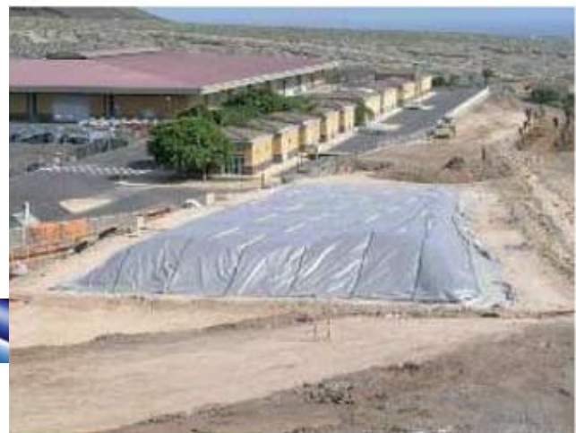
Acciona I+D+i ejecutó un terraplén con neumáticos fuera de uso en marzo 2007, en la obra Duplicación de calzada de la Autopista M-111 de Madrid.
