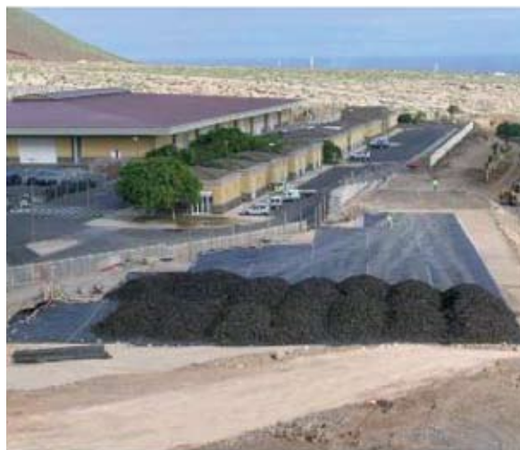
Acciona I+D+i ejecutó un terraplén con neumáticos fuera de uso en marzo 2007, en la obra Duplicación de calzada de la Autopista M-111 de Madrid.
