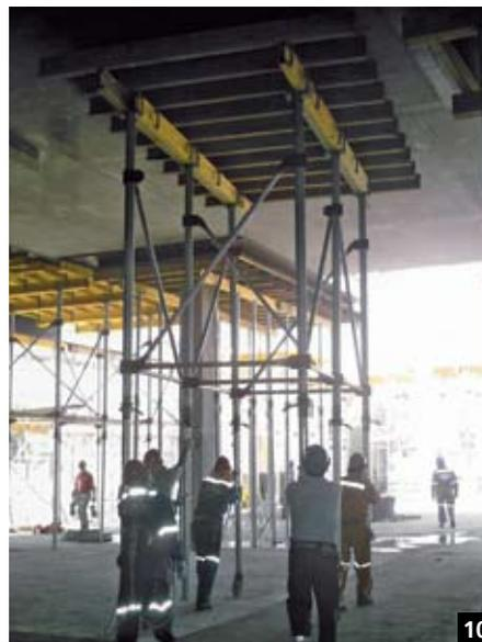
**4.** Una vez que todos los conectores se unieron a los puntales, se procedió a la unión de las horizontales y diagonales con los puntales dispuestos en forma vertical, generando torretas de seis apoyos.
