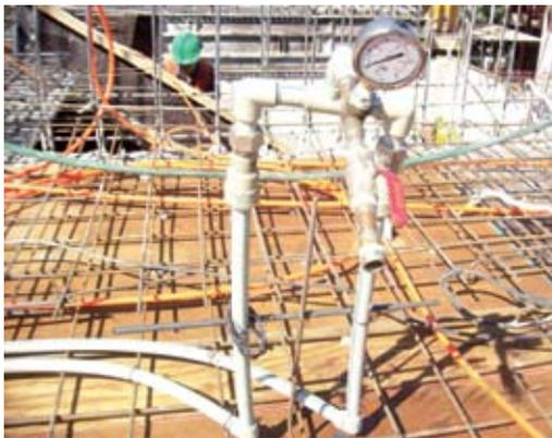
**Unión de la cañería de agua fría y caliente para probarlas simultáneamente.**
