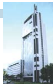
EDIFICIO CORPORATIVO CTC
