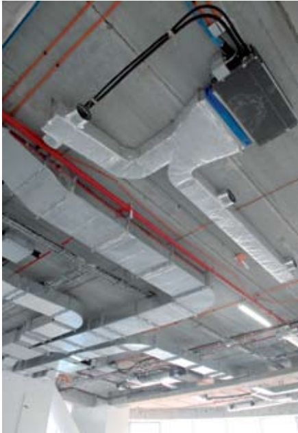
La instalación de los equipos de climatización se efectúa de abajo hacia arriba y a medida que se terminan los pisos, éstos quedan operativos.
