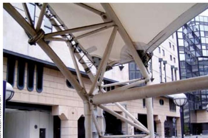
Detalle de corners y fijaciones de una tensoestructura.
