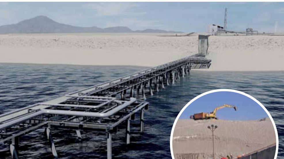
Imagen donde se muestra parte de las cañerías criogénicas que conducen el gas hasta llegar a la trinchera de hormigón que se eleva por 15 metros. Detalle real de los trabajos de excavación.
