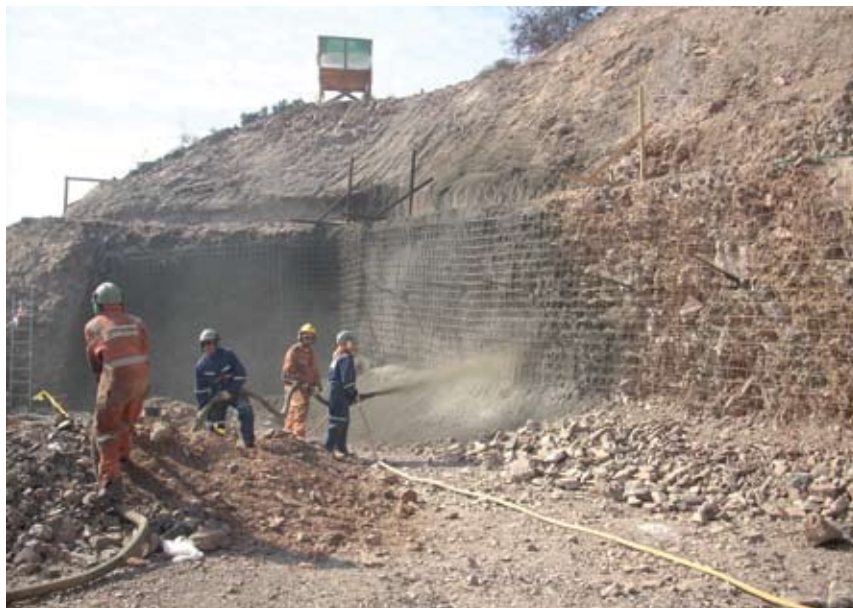
Hormigón proyectado sobre malla electrosoldada.
