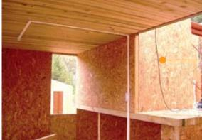
Instalación de muros en base a paneles de madera SIP 75 mm prefabricados, con una capa intermedia de poliestireno expandido.
