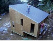
Las viviendas terminadas permiten observar las ventanas de aluminio y el revestimiento exterior de acero microondulado. La irregularidad del terreno y la espectacularidad del entorno natural suman elementos adicionales al proyecto habitacional.
