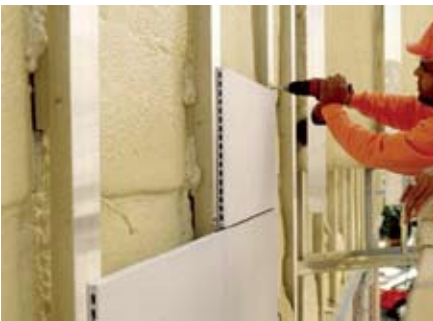
Instalación de fachada ventilada en la envolvente de un edificio.
