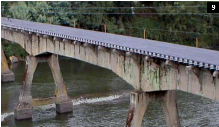
9. Tablero de madera tensado. 10. Aplicación del material asfáltico. 11. Colocación de tacos de madera para atenuar los efectos de movimientos sísmicos.
