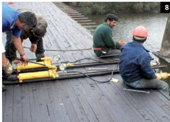
6. Alineación de las perforaciones. 7. Ensamblaje de tablero. 8. Tensado de barras.
