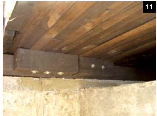
9. Tablero de madera tensado. 10. Aplicación del material asfáltico. 11. Colocación de tacos de madera para atenuar los efectos de movimientos sísmicos.
