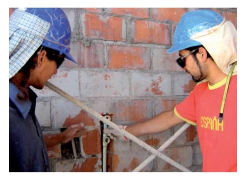
trabajos de tal manera que el manejo manual de fierro se realice de manera pausada, no sobrepasando el límite de carga permitido (50 kg) y en lo posible con apoyo de maquinaria. Tanto en el transporte como en el armado de las enfierraduras es importante evitar los sobreesfuerzos, por lo que se recomienda evitar posturas mantenidas más aún si se realiza fuerza
