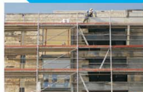
Andamios de Fachadas Layher en Obra Santa María Polo Golf Ejecución: Constructora Ingevec S.A.
