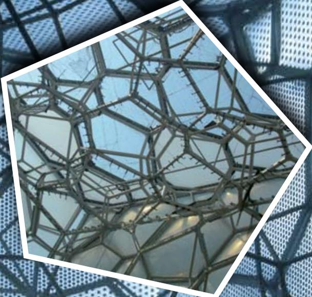
Vista interior de la trama celular del Cubo de Agua donde se observa que no se repite ninguna figura de su membrana. Arriba, un detalle de la estructura metálica. Abajo, estructura exterior, cuyos elementos fueron sometidos a 190 cargas de prueba distintas.
