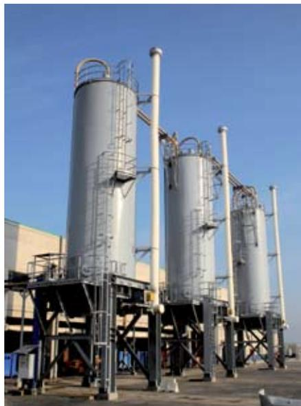
cada uno y donde se aloja el lodo final por cerca de ocho horas. “El montaje se realizó en tres fases: El montaje de la estructura base, fabricada en maestranza y ensamblada en terreno. El montaje de los silos, elaborados en su totalidad en maestranza y cuyo montaje en terreno se realizó con 2 grúas de 80 toneladas. El montaje del sistema de descarga de lodos, fabricado en Alemania y montado en terreno. Cada silo pesa alrededor de 30 t con una altura total de 20 metros”, indica Harvey Rojas.
