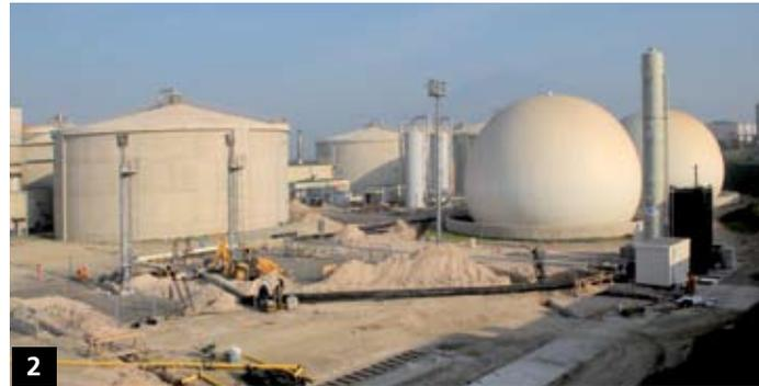
A nivel constructivo los anillos de concreto de los digestores se armaron en tres etapas. “Teníamos dos juegos de moldajes, cuando se completaba una etapa, pasábamos a la siguiente. Trabajamos con una secuencia muy rápida. Las trepas de moldaje eran de tres metros. Mientras en un digestor hacíamos una losa, en el siguiente estábamos en el techo”, comenta Burstein.
