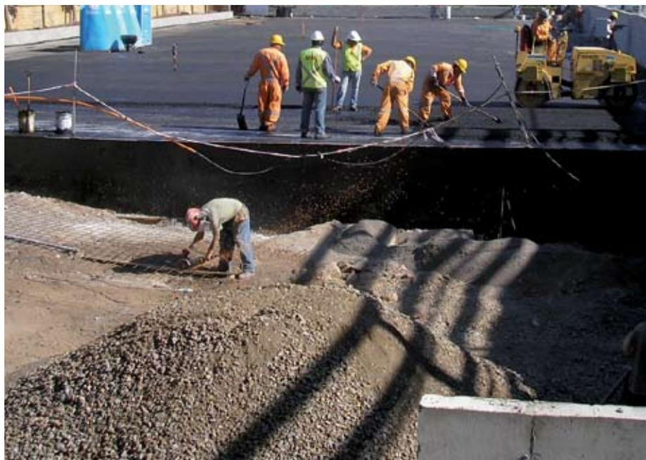
Las losas pueden sufrir inconvenientes a causa de las vibraciones provocadas por el rodillo compactador. Por ello, los expertos sugieren no vibrar sobre ellas, ya sean en superficie o subterráneas. El proyectista de pavimentos debe asesorarse para determinar si la losa se puede vibrar, conocer su resistencia, a qué tipo de carga será expuesta y por cuánto tiempo.
