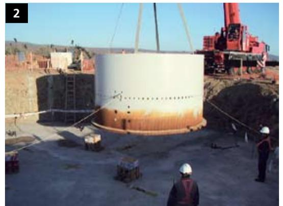
Una vez instalado y hormigonado el anillo base; pilar fundamental de cada aerogenerador, la grúa toma el primer tramo de tubería y lo deja en posición vertical ensamblado con el anillo. Personal especializado realiza la unión mecánica instalando los pernos de ensamblaje en cada una de las 140 perforaciones.
