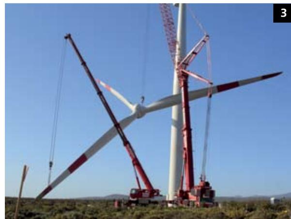
**Paso a paso del montaje del rotor completo, que incluye las tres aspas y el hub. Una de las faenas críticas debido al viento que movía las aspas.**
