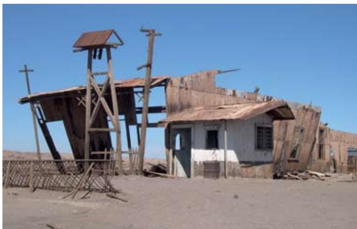
vestimientos de los muros son de plancha de zinc onduladas (calamina). Las estructuras de madera en cubiertas tienen una rica variedad de ensambles y uniones, presentando diversas tipologías de armaduras de cubiertas: sistemas con pendolón; cercha inglesa; armadura trapecial; o la compuesta por dos pares y un tirante, un pendolón y varias tornapuntas.
