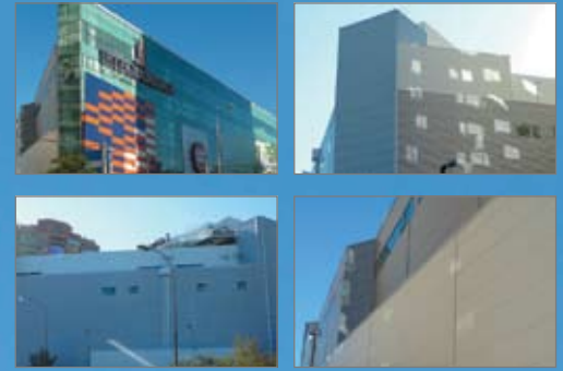
Productos Destacados H Wall y Super Wall liso Obra Mall Manquehue
