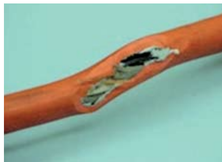
Cables de extensión: deben tener aislación adecuada al trato y al ambiente de la faena.
