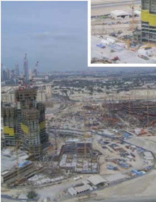
Las faenas avanzan a un ritmo acelerado, con un promedio de un piso cada tres días. El sistema de construcción se sustenta en la ejecución de los muros con moldaje autotrepante anclado a la estructura.
